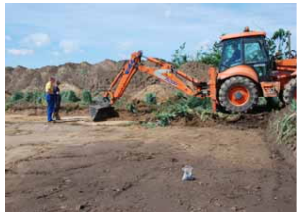
Muldafrømning med rendegraver
